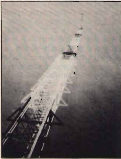
Una delle torri di sostegno per l'antenna di WWVB/WWVL; l'altezza è di 122 metri.
