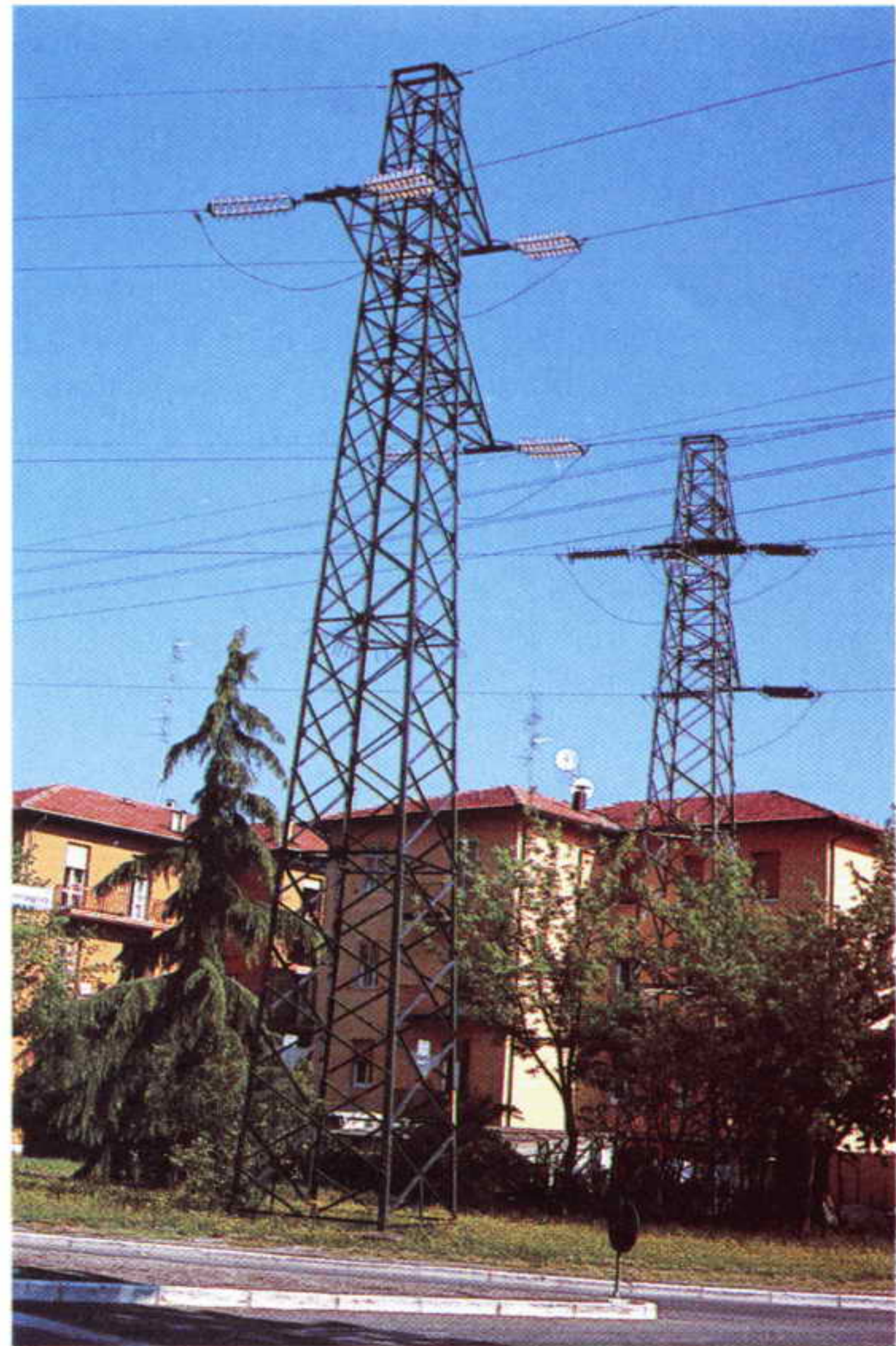
Fig.2 In questa foto vi mostriamo due linee di alta tensione che passano vicinissimo alle case. Misurandone il livello, già al piano terra abbiamo rilevato ben 2,80 microtesla, cioè una intensità 14 volte superiore al valore minimo consentito.
