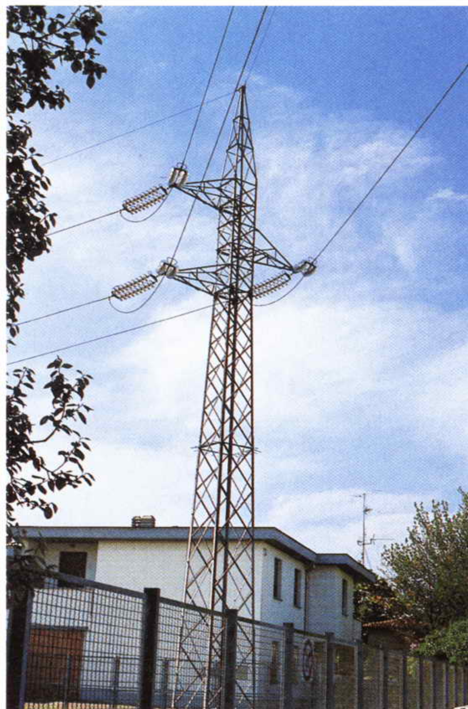
Fig.5 Se vicinissimo alla vostra casa passa una Linea di alta tensione, misurate quale livello ELF è presente sul cuscino del vostro letto. Se rilevate un valore superiore a 0,20 microtesla vi conviene spostare il letto.
