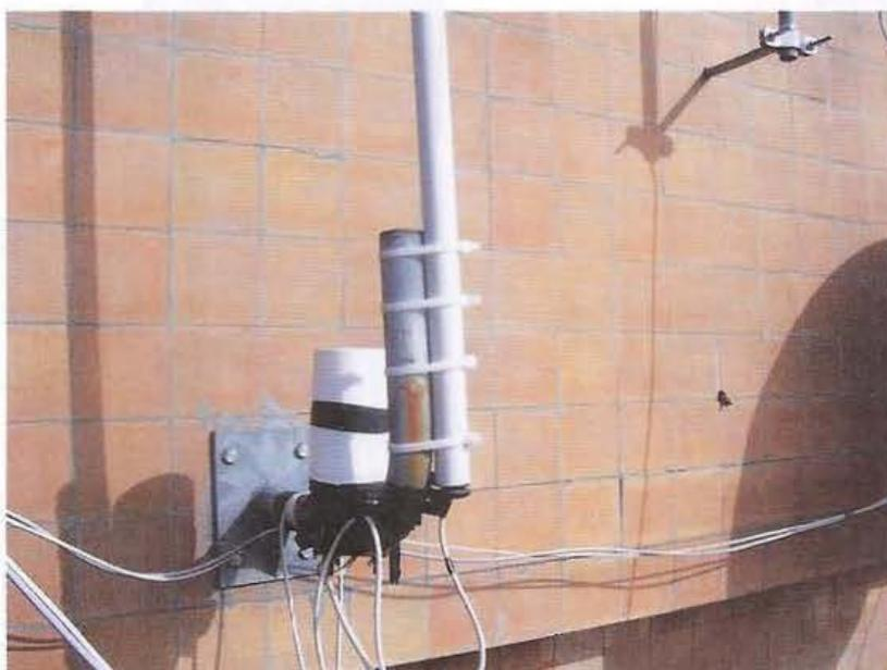
**Fig.6** Ecco come abbiamo risolto il problema del fissaggio del tubo contenente l'amplificatore.
